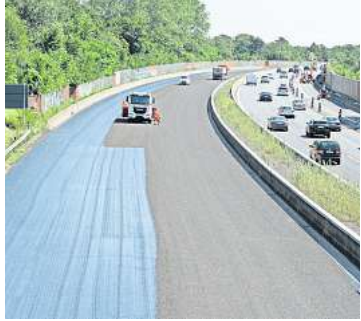
Glück mit dem Wetter: Trockenheit begünstigte den Austausch der Asphaltdecke, den die Autobahn GmbH auf der A2 vornahm.
